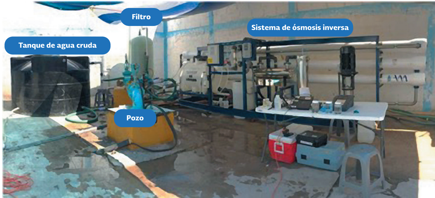
Pruebas de laboratorio con planta piloto de 1 L/s.
