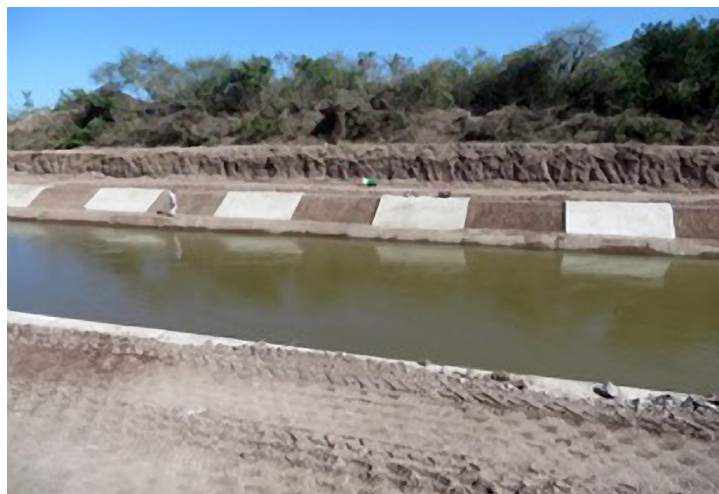
Trabajos de sobreelevación del Canal Principal Humaya.
