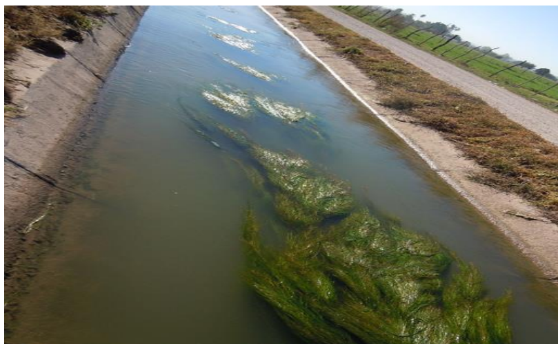
Canal de riego infestado por algas y macrofitas.
