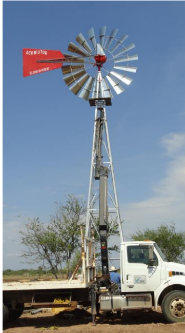
Instalación del molino de viento.
