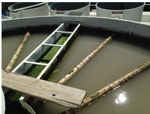
Clarifloculador de la potabilizadora antes de la rehabilitación.
