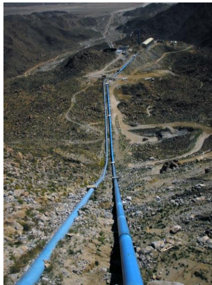
Vista panorámica del acueducto.
