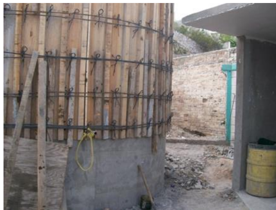
Cimbra del arreglo del Pozo No. 6, Gómez Palacio, Durango.
