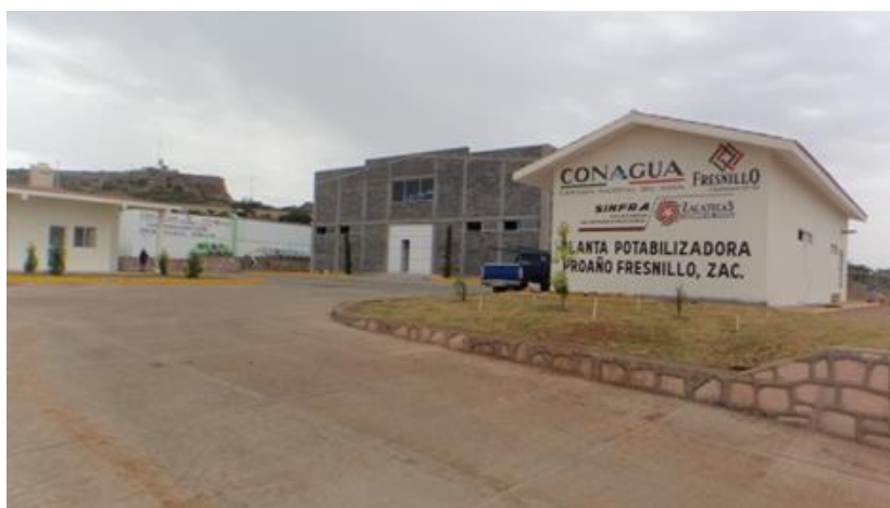
Vista general de la planta.
