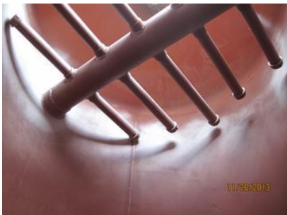
Múltiple distribuidor de agua con recubrimiento primario epóxico en Interior de un tanque.
