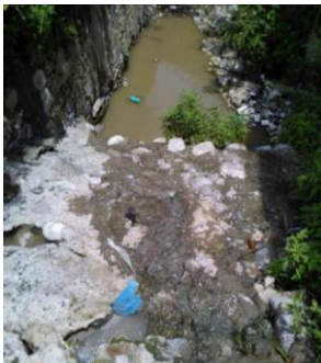
Descarga de aguas residuales al río Tomatal.
