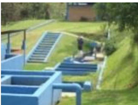
Planta de tratamiento de agua residual Rastro, Valle de Bravo, Estado de México.
