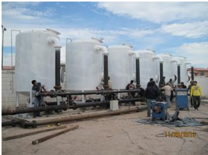
Instalación de tuberías, conexiones y accesorios en tren de filtración del pozo 35.
