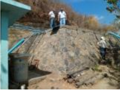
Revisión de la infraestructura para agua potable.
