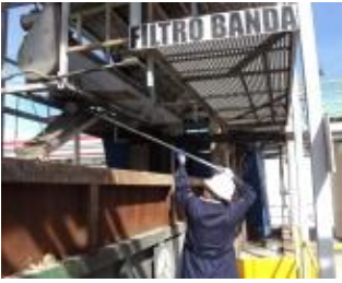
Muestreo del lodo deshidratado de la unidad de proceso filtro-banda, Saltillo, Coahuila.
