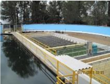
Potabilizadora Los Filtros.
