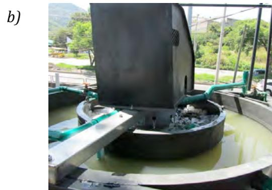
**Detalles de la alternativa: a) Conexión del tubo del influente al distribuidor del agua en la parte superior del reactor; b) Conexión del tubo de la recirculación del efluente.**
