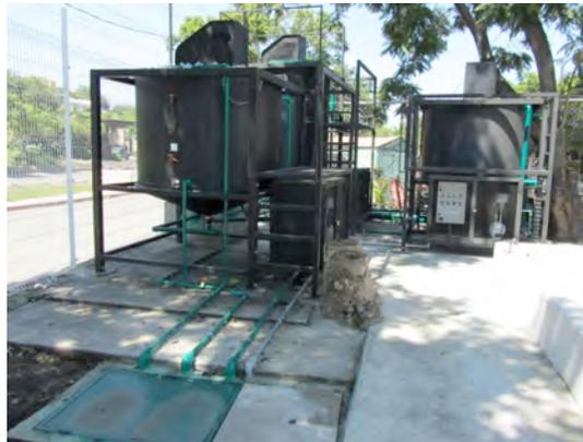
**Prototipos operando a escala real: BIOSTAR y sus dos alternativas para mejorar la remoción biológica de nitrógeno en el tratamiento de las aguas residuales municipales.**
