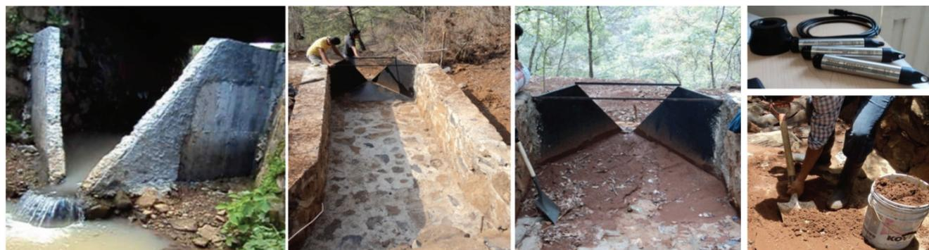
Vertedor de Cerritos (HL) y vertedores en Ichupio H1 (con obras), H2 (sin obras). Muestreo de sedimentos y sensores electrónicos (cauces intermitentes).
