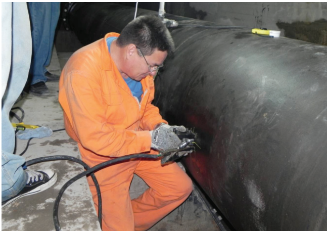
Instalación de un sensor de medición ultrasónico.
