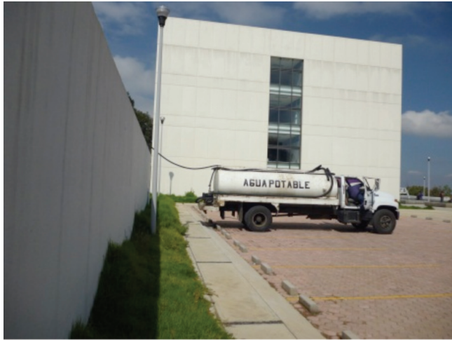
Abastecimiento de agua mediante pipas en el tecnológico de Milpa Alta, debido a la falta de red pública de agua potable.
