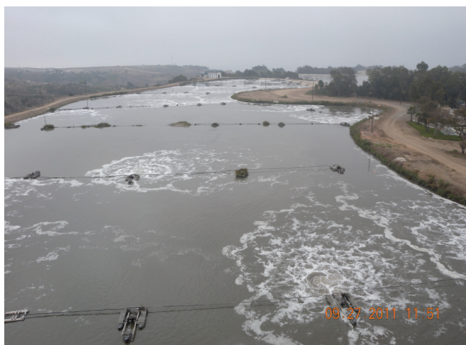
Sistema lagunar de tratamiento actual de la PTAR San Antonio de los Buenos.
