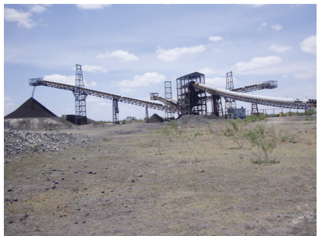
Extracción de carbón en mina.
