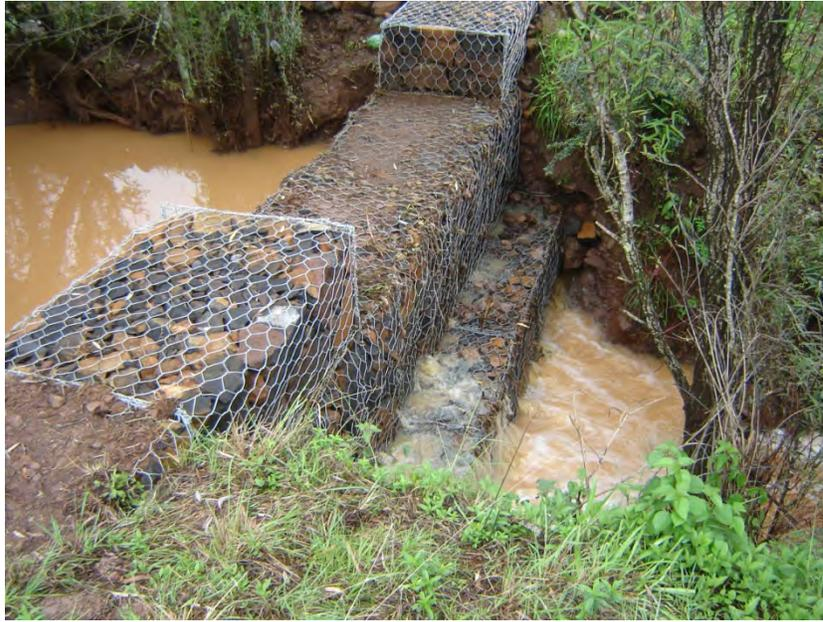
**Represa de control de azolves funcionando, Crucero de Chapultepec, Pátzcuaro.**
