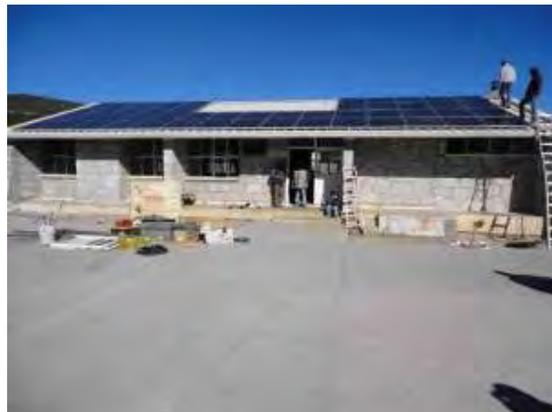
Arreglo final de los paneles fotovoltaicos.
