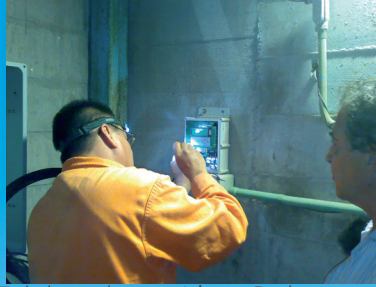
Trabajos en la presa Lázaro Cardenas.
