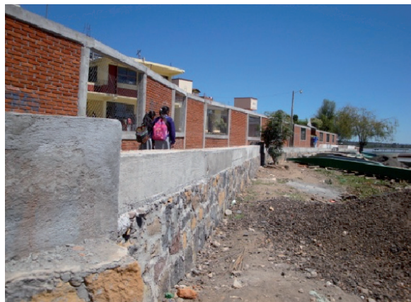
Encofrado de colector frente a la primaria.
