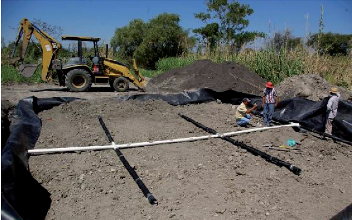
Instalación de los tubos de recolección del agua tratada por el humedal experimental.
