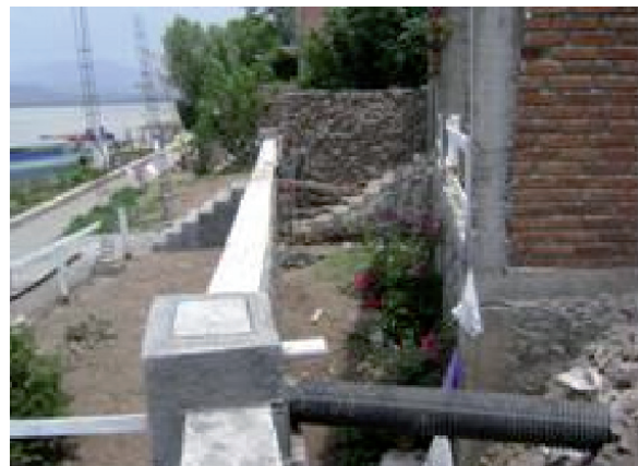
Encofrado en el tramo de rehabilitación de colector general.
