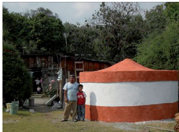
Cisterna de 20 m 3 en Coajomulco.
