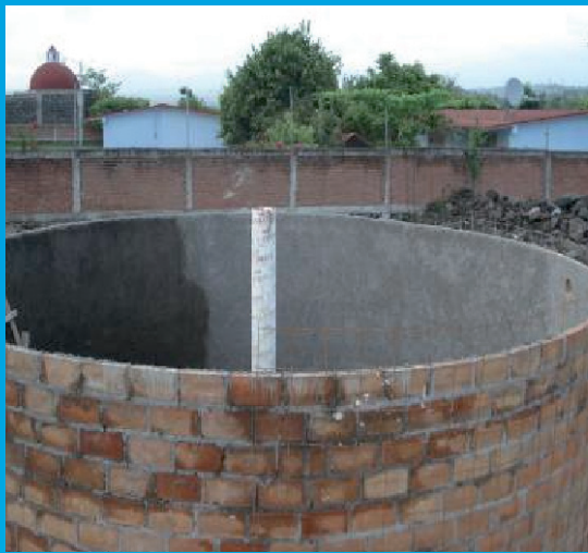
Emiliano Zapata, construcción de cisterna.
