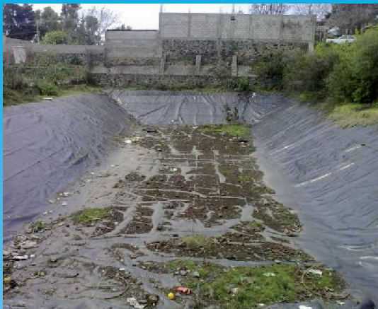
Olla 2 antes de la rehabilitación.
