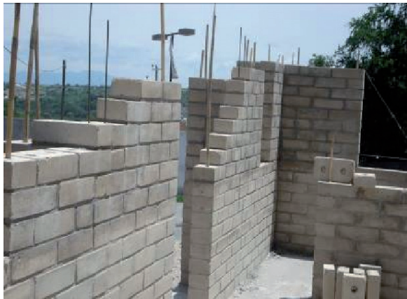
Xochitepec, construcción de muros.
