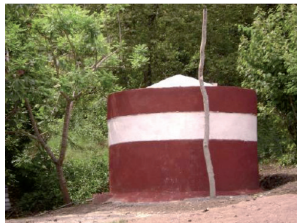
Cisterna instalada en El Tzajib, Tanlajás, San Luis Potosí.
