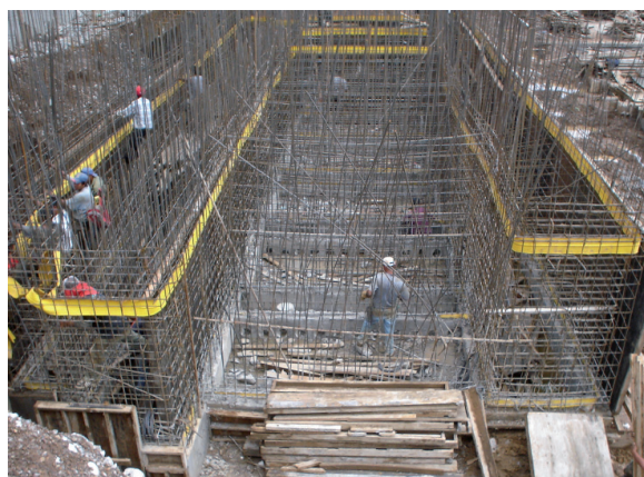
Armado de la batería de filtros de tasa declinante.
