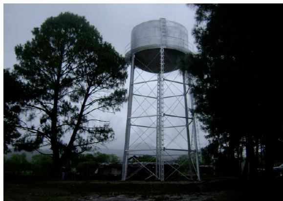
Tanque elevado con capacidad de 150 m 3 en la red de distribución de agua potable de Erongarícuaro.
