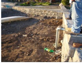
Entronque línea de tubería galvanizada de 3" de diámetro del bombeo al colector encofrado para el colector de Janitzio.
