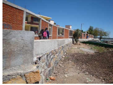
Encofrado de colector frente a la primaria.
