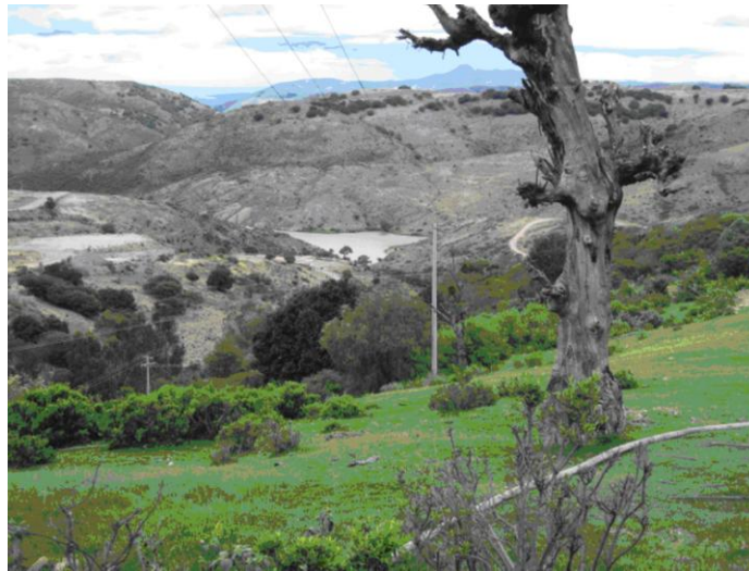
Vista de la presa de Peregrina desde el sitio de la planta potabilizadora demostrativa.
