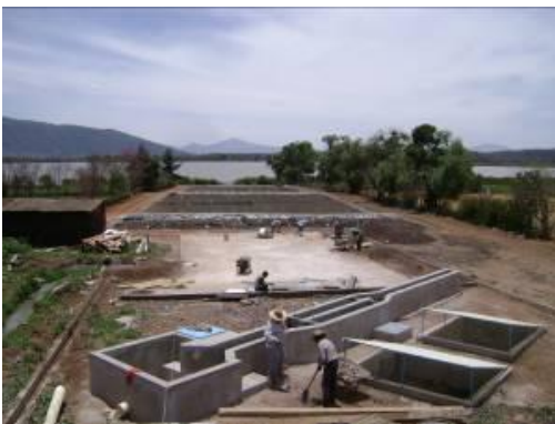
Vista general del humedal.
