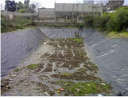
Olla 2 antes de la rehabilitación.
