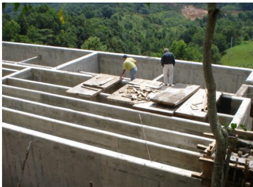
Vista de la cámara de floculación.
