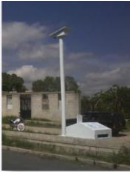
Instrumentación y medida del flujo con caudalímetro IMTA e infraestructura modernizada en el DR 023, San Juan del Río, Querétaro.
