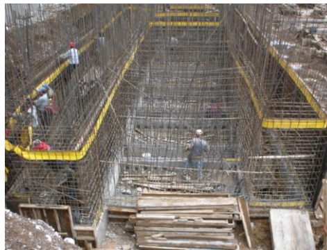
Armado de la batería de filtros de tasa declinante.
