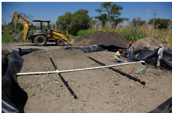
Instalación de los tubos de recolección del agua tratada por el humedal experimental.
