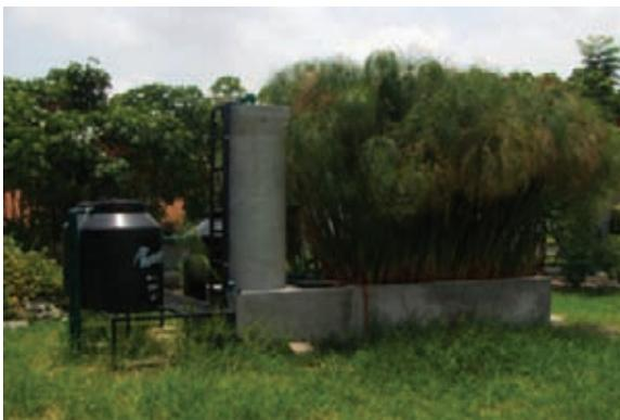
Acoplamiento del humedal con el biofiltro.
