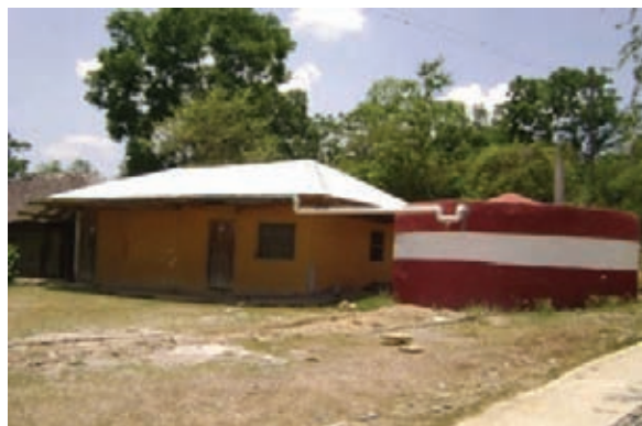
Cisterna de 50,000 litros y sistema de captación en Santa Martha.
