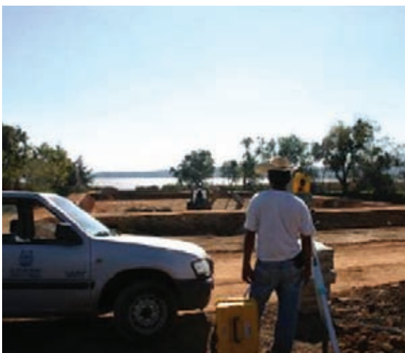
Instalación del humedal en San Jerónimo Purenchécuaro.
