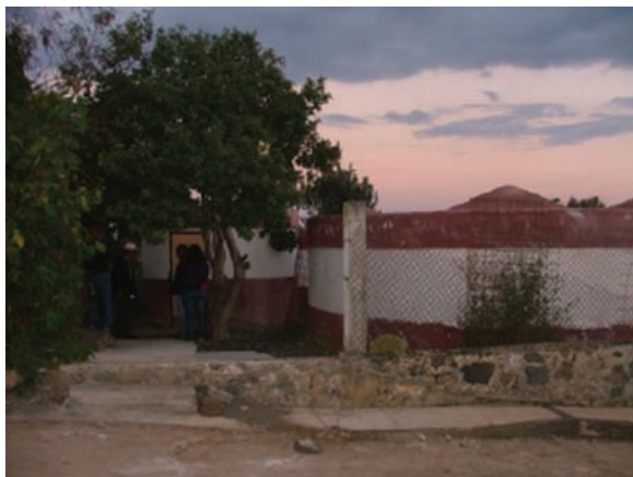
Almacenamientos (100,000 litros) y planta de tratamiento en Napízaro, Erongarícuaro.
