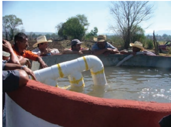
Etapa de llenado del tanque de descarga de fondo para riego parcelario en El Jagüey, Tzintzuntzan.
