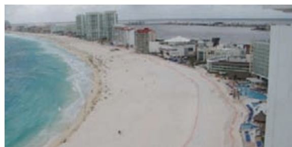
Panorámica hacia el sur de la isla barrera de Cancún, en la que se aprecia el nuevo ancho de playa seca logrado después del vertido de arena.
