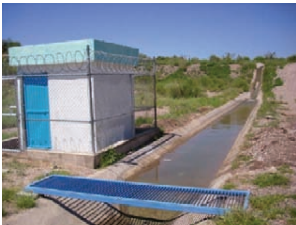
Estación de medición con un aforador de garganta larga (izquierda). Determinación del caudal con un equipo de perfilación acústica Doppler portátil (derecha).
