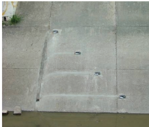
Instalación de tiempo de travesía en el DR 030 Valsequillo, Puebla.
