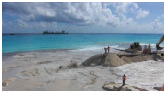
Inicio de los trabajos de vertido de arena en la isla barrera de Cancún el 1° de noviembre de 2009.
