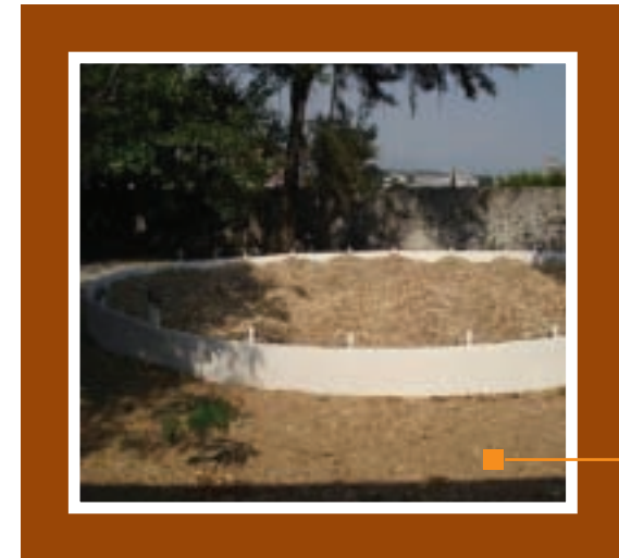
Biofiltro sobre lecho orgánico.
