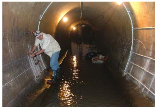
SUPERVISIÓN DE ALINEAMIENTO DE SENSORES DE VELOCIDAD EN EL TÚNEL DE LA PRESA EUSTAQUIO BUELNA, SINALOA
