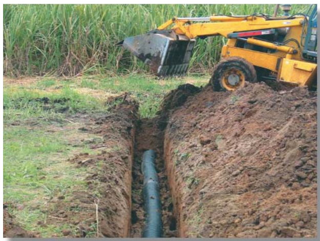
INSTALACIÓN DE DRENAJE PARCELARIO
