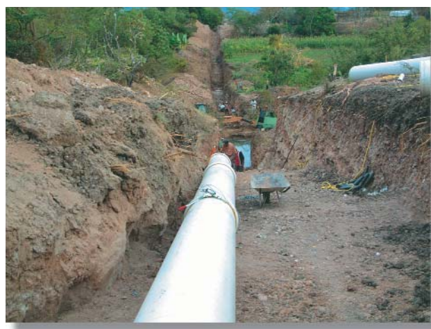
ENTUBAMIENTO DE LA RED DE CONDUCCIÓN, DISTRITO DE RIEGO 068 TEPECOACUILCO-QUECHULTENANGO, GUERRERO
