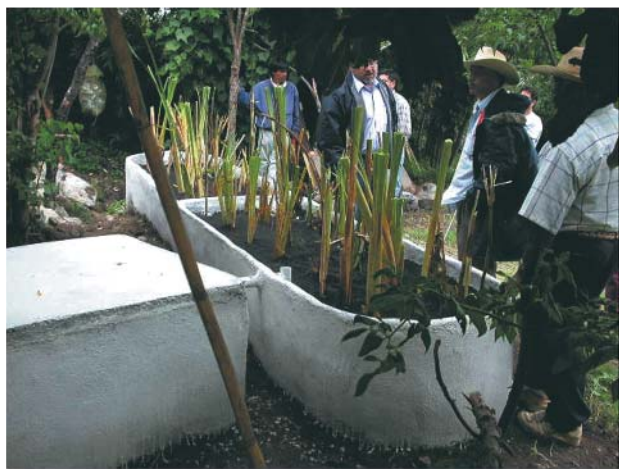
TALLER CONSTRUCCIÓN DE BIOFILTRO: TRATAMIENTO DE AGUAS GRISAS DOMICILIARIAS. COMUNIDAD DE SAN JERÓNIMO PURÉCHECUARO, QUIROGA, MICHOACÁN
