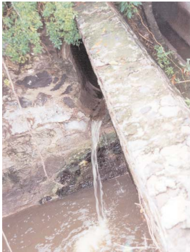
ESTRUCTURA DE DESCARGA DE EFLUENTES
