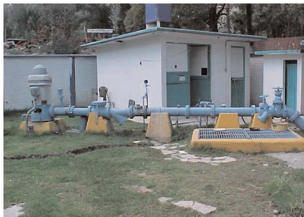
INSTALACIÓN DE MACROMEDIDORES EN POZOS DE EXTRACCIÓN
