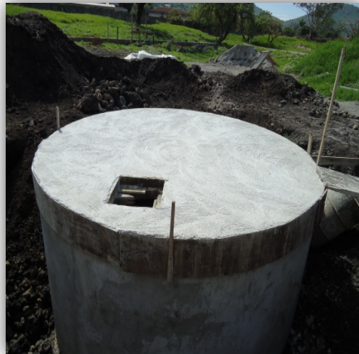
(Preparación de emparrillado y colado de tapa de cisterna)
