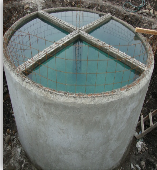
(Colocación de castillos y traveses en interior de cisterna)
