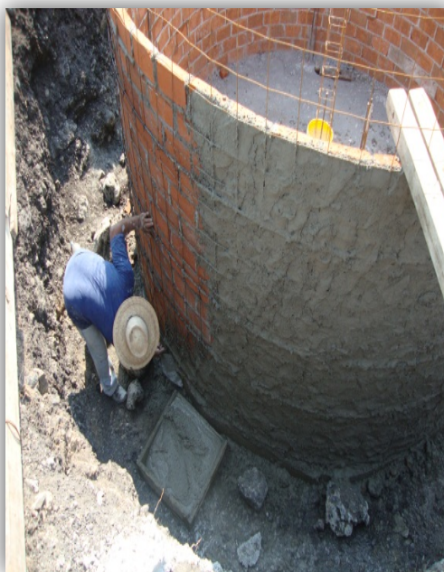
(Colado de base, pegado de tabique instalación de malla y acabados)
