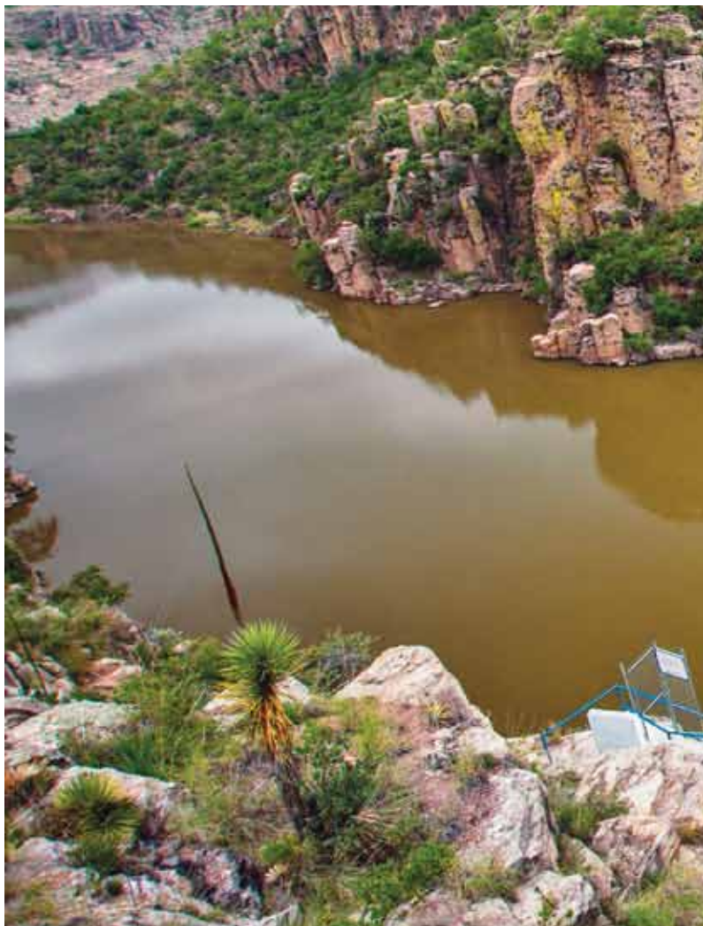
Presa Potrerillos, Aguascalientes.
