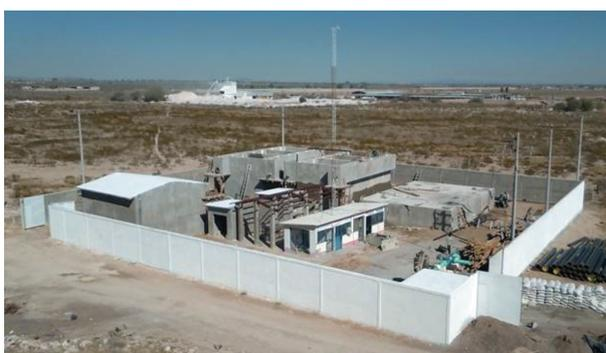
Construcción de planta de filtración directa de 193 L/s para pozos Transportes I y III, Durango.
