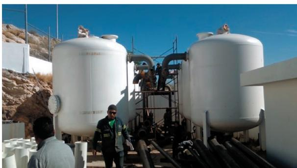
Construcción de planta de filtración directa de 112 L/s para pozo 5, Durango.
