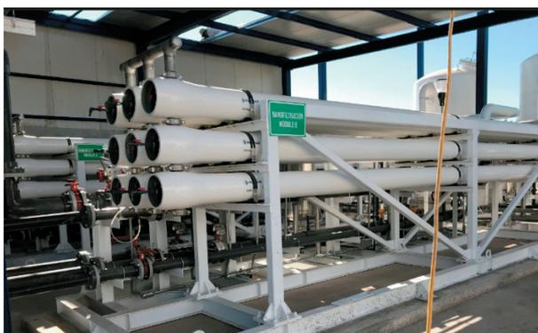
Planta de prefiltración y nanofiltración de 42 L/s para el pozo San Ignacio, San Pedro, Coahuila.
