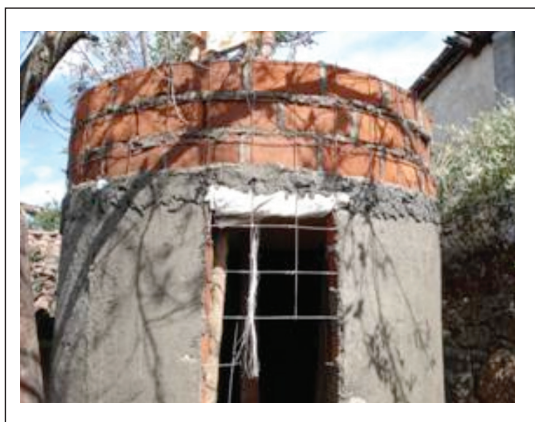
Figura 3.21. Se coloca el muro capuchino del tinaco.
