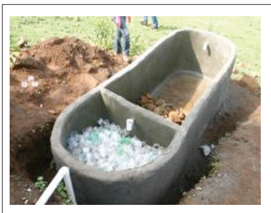
Figura 5.7. Colocación del PET.
