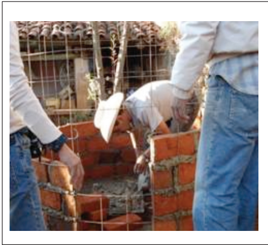
Figura 3.15. Se coloca el tubo para el sanitario.
