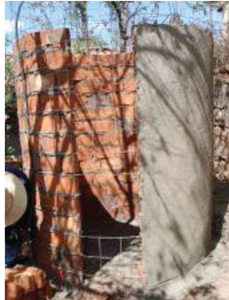
Figura 3.16. Se coloca el tubo para la coladera.
