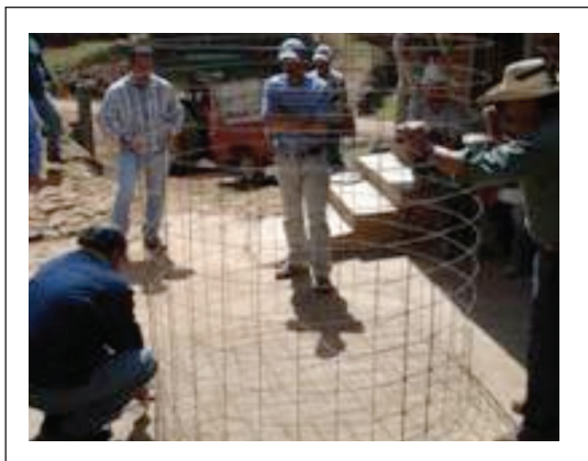
Figura 3.7. Se invierte el anillo para cortar la malla del piso del tinaco.
