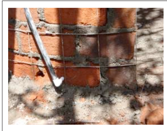
Figura 3.23. Se Coloca la manguera para el agua del WC.
