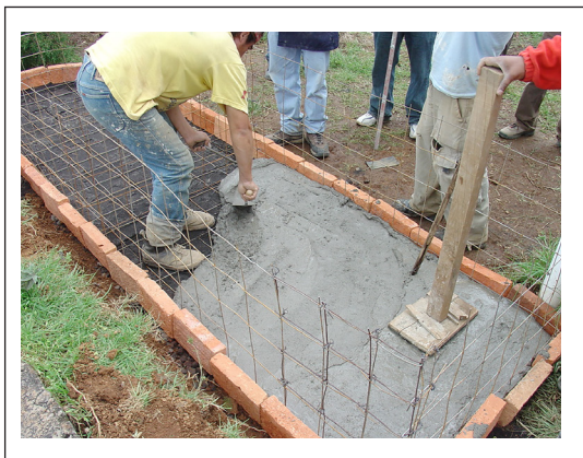
Figura 5.3. Colado de la losa de fondo del humedal.
