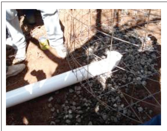
Figura 3.9. Se coloca el tubo para el sanitario.
