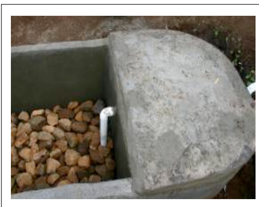
Figura 5.8. Se coloca la tapa y se sella.
