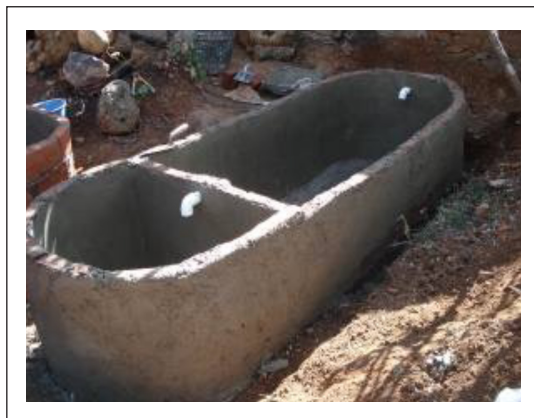
Figura 5.6. Conexión a la salida del filtro de materiales graduados.
