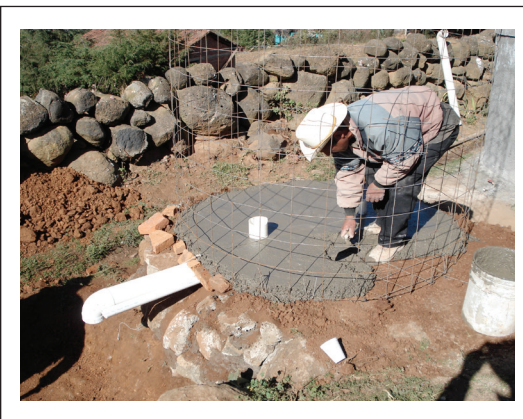
Figura 3.12. Cuidar que la tapa del tubo no se tape con mezcla.
