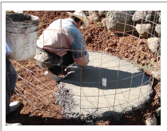
Figura 3.11. Se hace el colado del piso.
