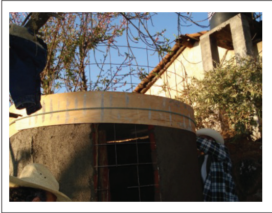
Figura 3.19. Se coloca un anillo de triplay para el colado.
