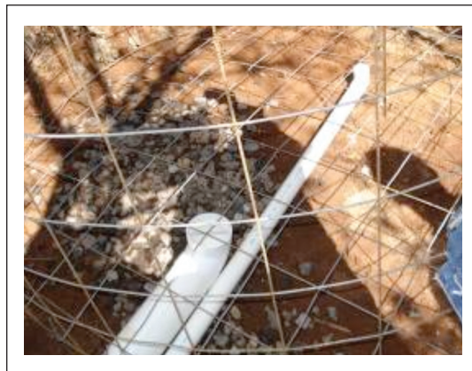
Figura 3.10. Se coloca el tubo para la coladera.
