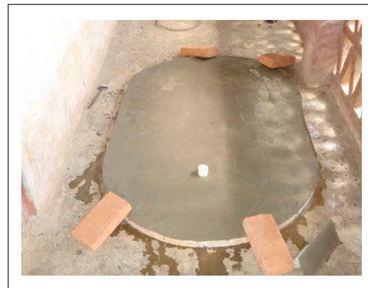
Figura 4.11. Se coloca el tubo para la salida del gas.
