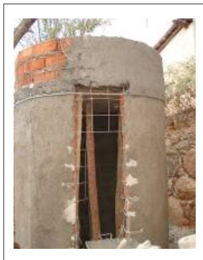
Figura 3.22. Se repella rústico por fuera.
