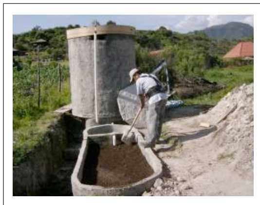
Figura 4.12. Se coloca el tubo en el tanque séptico.
