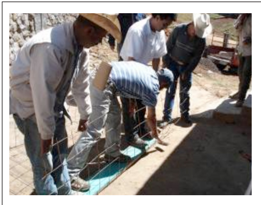
Figura 4.3. Se repella con acabado fino por dentro para evitar filtraciones.
