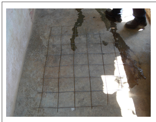
Figura 4.10. Malla para la tapa.
