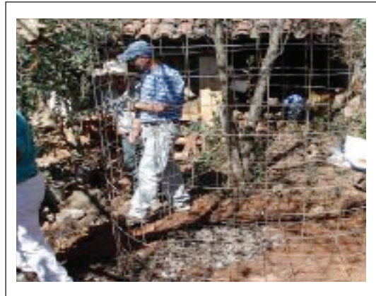
Figura 3.8. Colocación del anillo en la superficie preparada para el baño.
