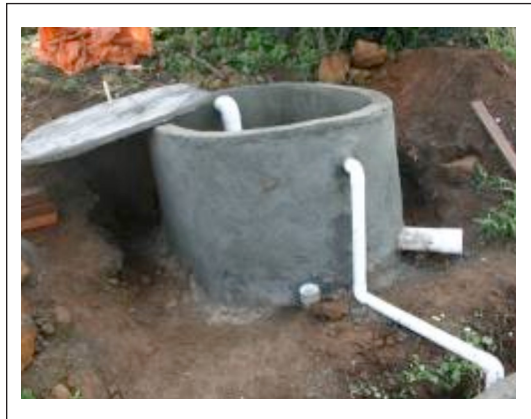
Figura 5.13. Conexiones entre cámaras.
