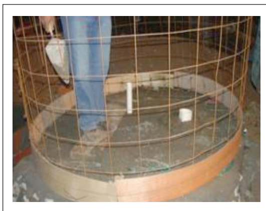
Figura 3.14. Se coloca la caseta sobre el tanque séptico.
