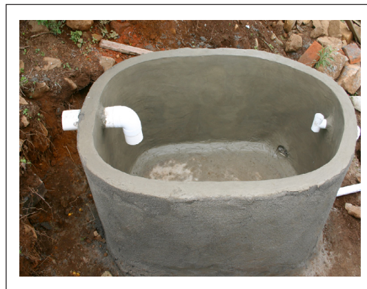
Figura 4.8. Conexiones en el tanque séptico.
