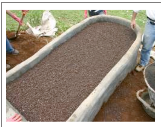
Figura 5.11. Capa de grava (35 cm).).
