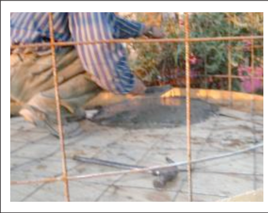
Figura 3.20. Se hace el colado de 5 cm.
