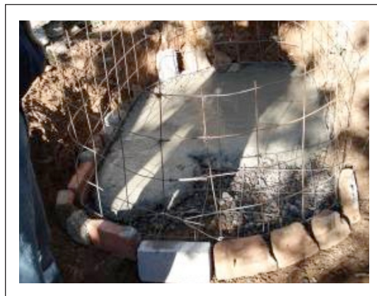
Figura 4.6. Se colocan tabiques alrededor y se hace el colado.
