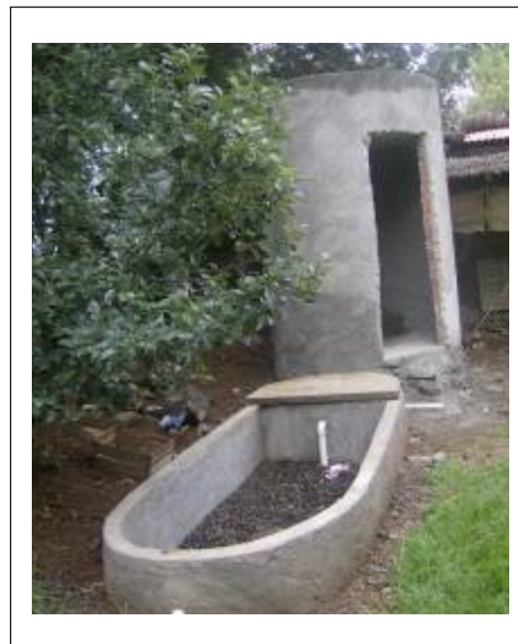
Figura 5.10. Capa de grava (35 cm).).
