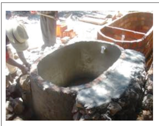
Figura 3.13. Se hace la mampostería a los lados del tanque séptico.
