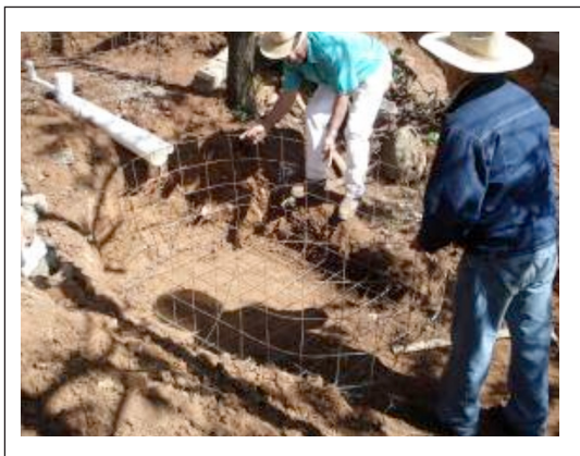
Figura 4.5. Se coloca el armado en el terreno nivelado.
