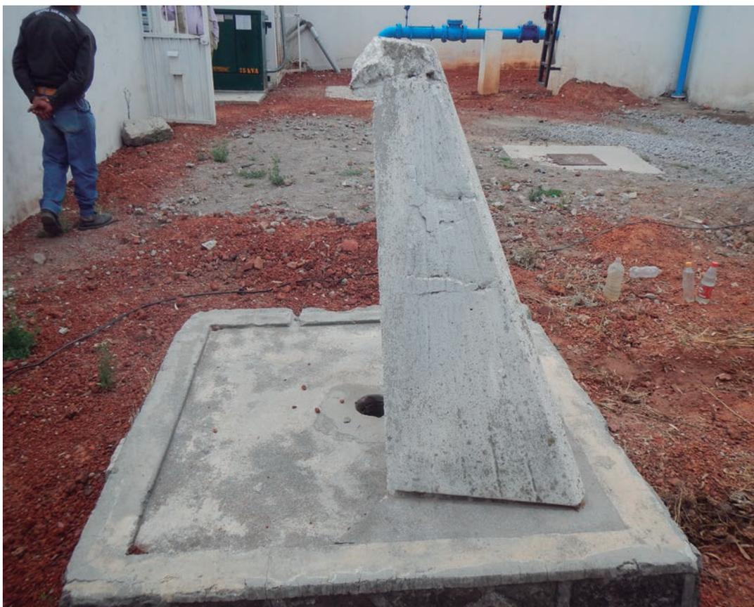
**Figura 5.1.** Hidrante público del año de 1970, encontrado en las instalaciones del Pozo no.7 de San Mateo Atenco, Edo. de México. Era parte del sistema rural construido por la Secretaría de Salubridad y Asistencia (SSA) a través de la Comisión Constructora e Ingeniería Sanitaria (CCIS), con el apoyo de la comunidad y el Gobierno del Estado.
