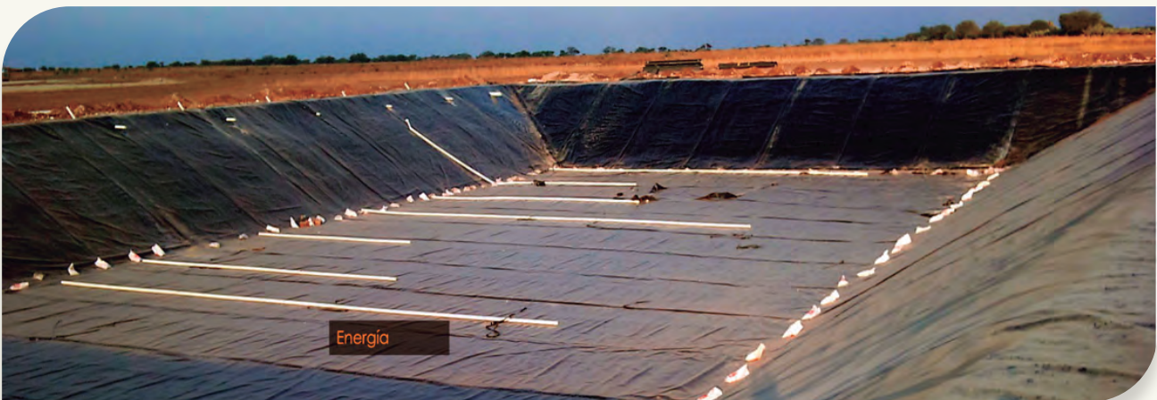
Geomembrana y sistema de recolección de gases
