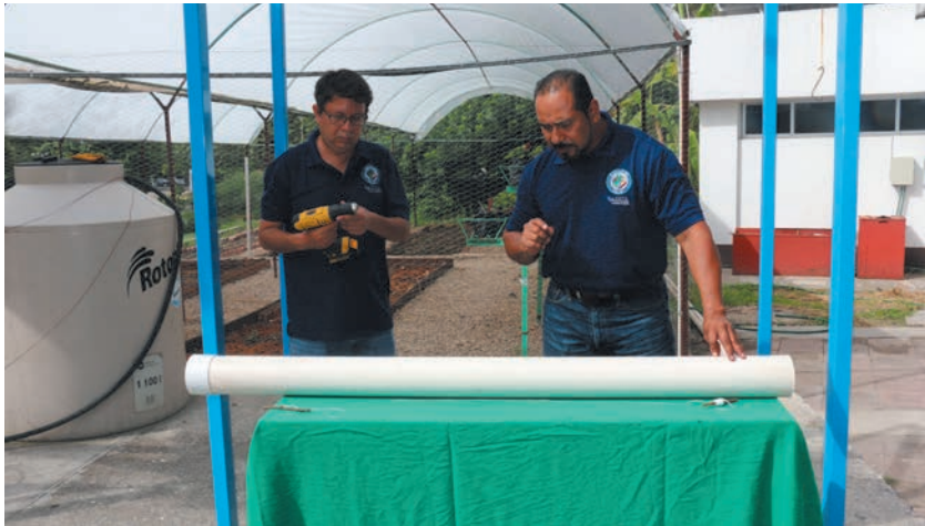
Figura 5.2. Marcado de la longitud del tubo.
