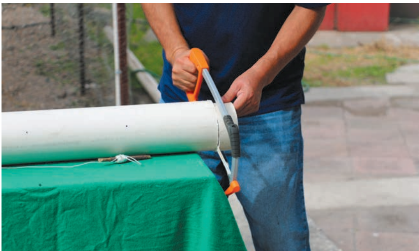
Figura 5.3. Corte del tubo.
