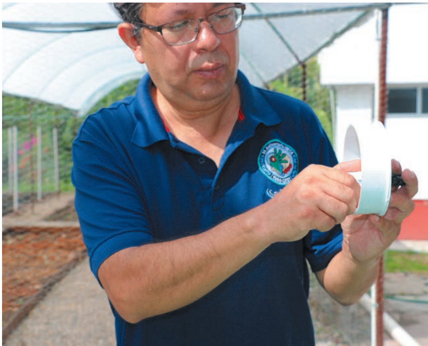
Figura 5.7. Colocación del cople de PVC.
