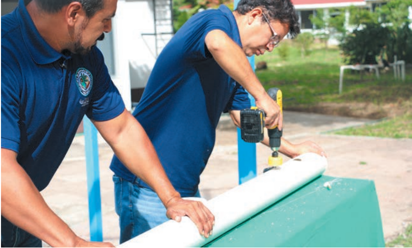
Figura 5.4. Perforación del tubo
