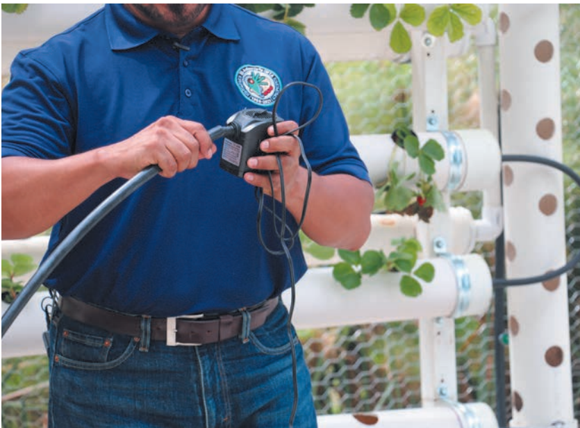
Figura 5.9. Colocación de la bomba.
