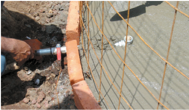
Figura 4.17: Colocación de la tubería de salida del agua dentro de la losa de fondo.
