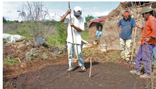
Figura 4.12: Dibujo del círculo de la cisterna y compactación del suelo y grava
