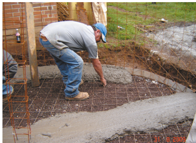
Figura 4.16: Colocación de tabique alrededor de la malla y colado de la losa de fondo
