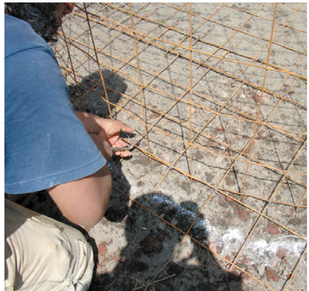
Figura 4.15: Amarre de la malla del cuerpo de la cisterna sobre la malla de fondo
