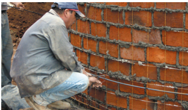
Figura 4.19: Colocación de las varillas de refuerzo
