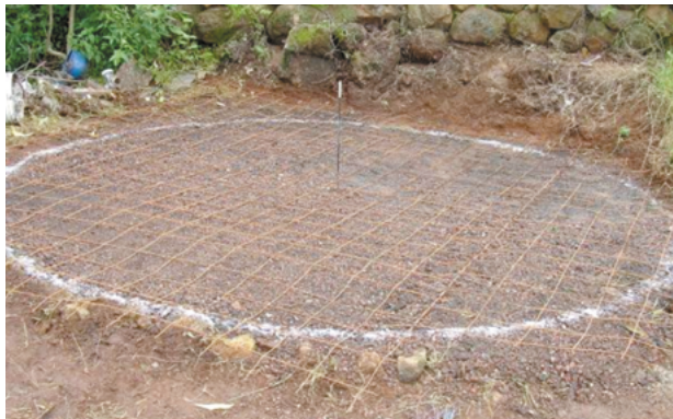
Figura 4.13: Colocación de la malla de fondo
