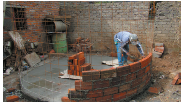
Figura 4.18: Colocación del muro tipo capuchino
