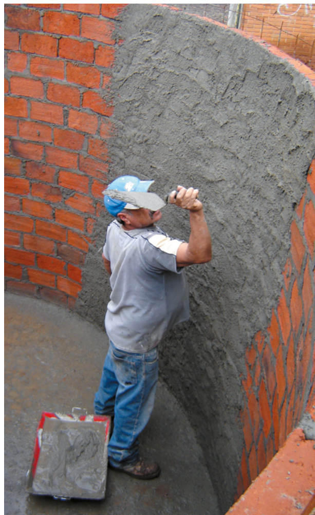
Figura 4.20: Aplicación del acabado interior (primera capa)
