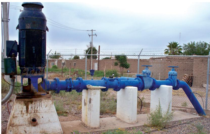
Figura 1. Pozo con equipo de bombeo para extracción de agua subterránea.
