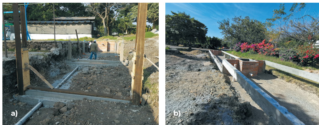
Figura 30. Nivelación del fondo del estanque: a) con tierra, b) con arenilla
