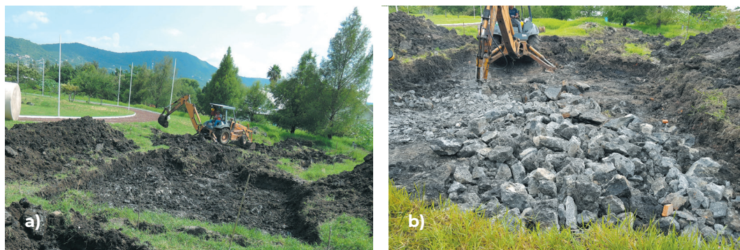
Figura 28. Excavación de los estanques. a) Los primeros centímetros de profundidad. b) Capa de roca.
