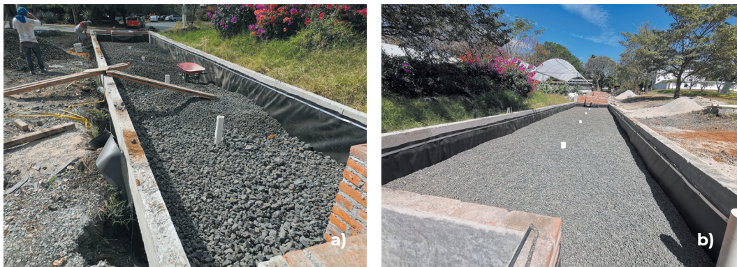
Figura 35. Colocación de las capas del medio filtrante: a) vista de tres capas, b) capa de la superficie.
