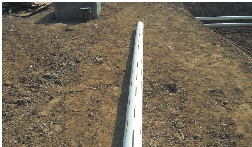
Figura 37. Detalle del ranurado de las tuberías.
