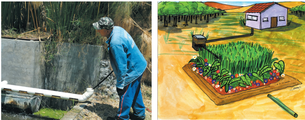
Figura 49. Limpieza de tuberías.
