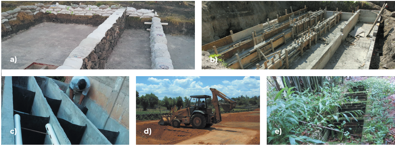
Figura 31. Formación de los bordos con distintos materiales. a) Muro de piedra. b), c) y e) Muros de concreto. d) Tierra mezclada con arcilla.
