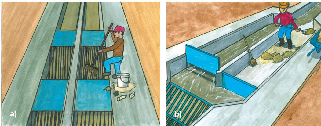
Figura 46. Labores de limpieza: a) retiro de basuras de las rejillas, b) extracción de sólidos del desarenador.
