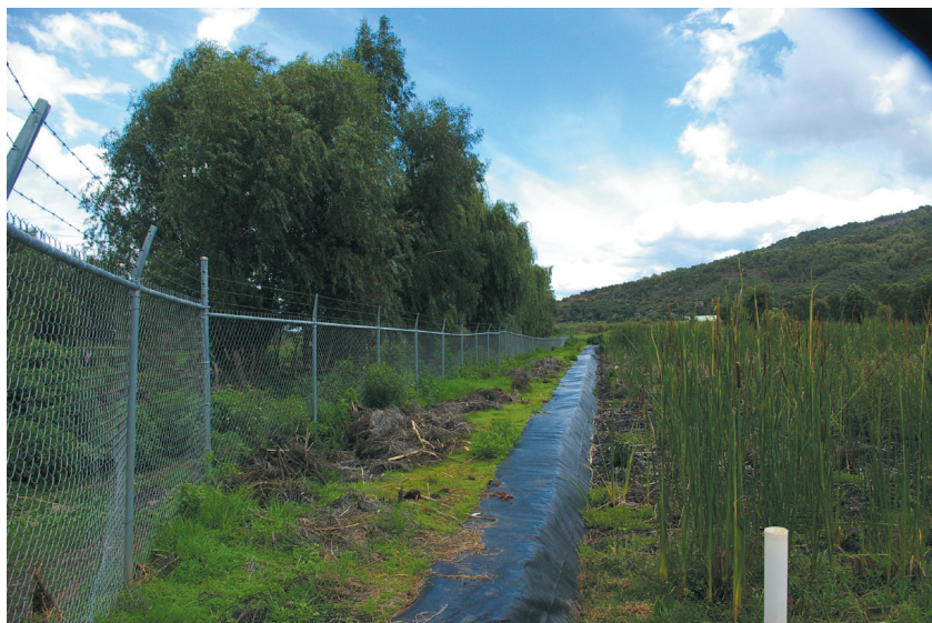
Figura 45. Protección del humedal mediante malla ciclónica.
