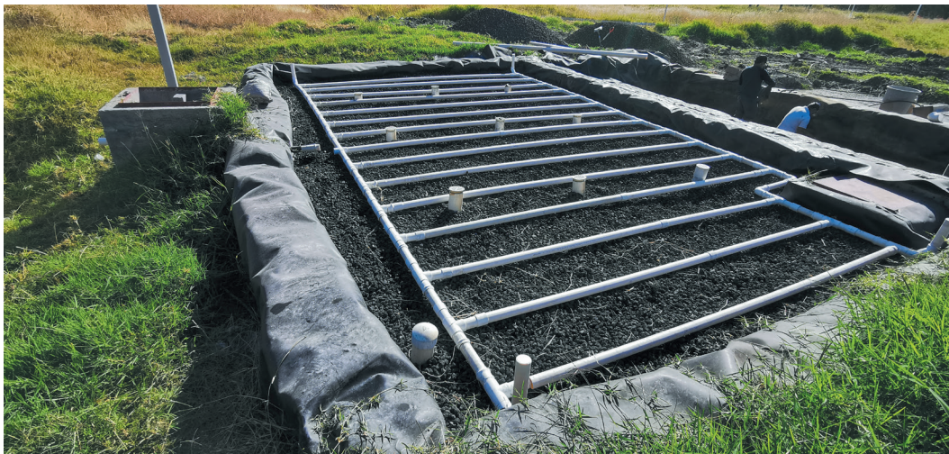
Figura 39. Instalación de la parrilla de tubería en la superficie de un humedal de flujo subsuperficial vertical.
