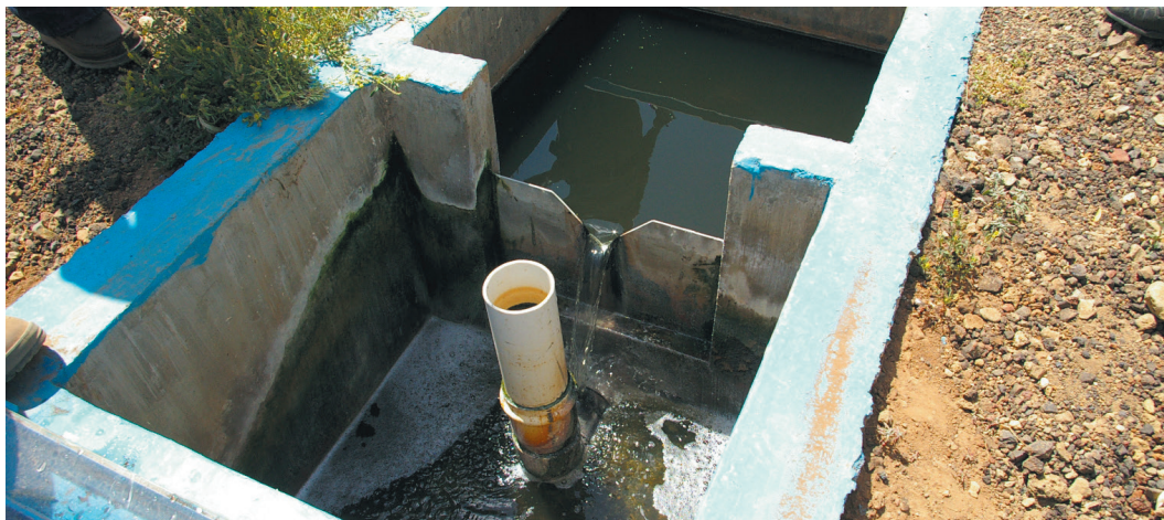
Figura 42. Caja de paso con vertedor triangular.
