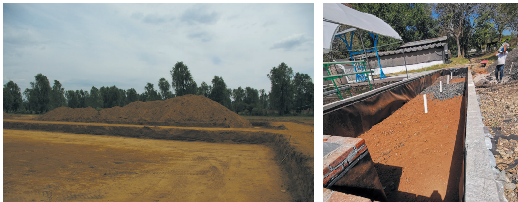
Figura 33. Colocación de la capa de arcilla.
