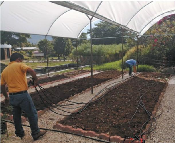
**Figura 29.** *Instalación de mangueras de 16 mm.*
