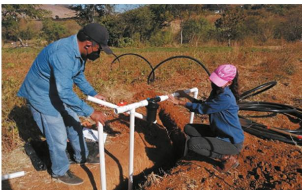
**Figura 27.** Instalación de una unidad de control de riego.
