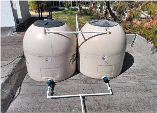
**Figura 32.** Depósitos conectados en paralelo.
