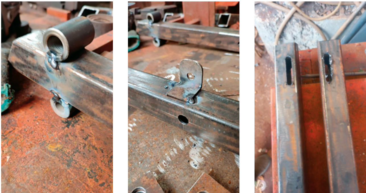
Figura 19. Detalles de la construcción del elemento B.
