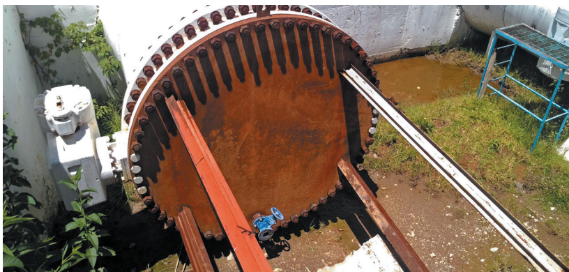
Preparación para conexión de la línea, 3 desde la planta de bombeo 5.
