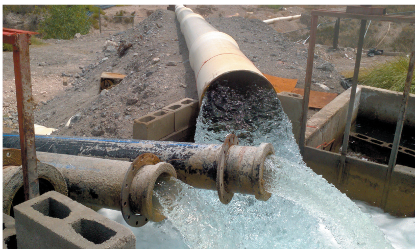
Sitio de descarga 1. Guadalupe Sur. Gasto 792 L/s, en promedio.
