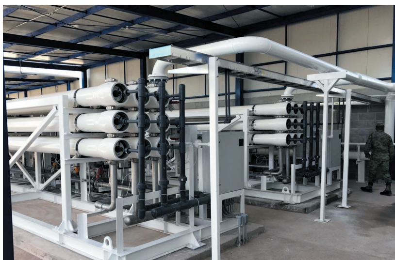
Planta de nanofiltración de 42 L/s para el pozo San Ignacio, en San Pedro, Coahuila.
