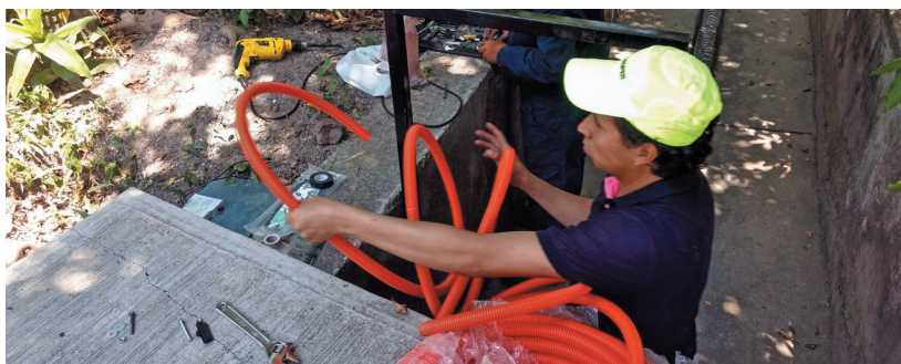
Reinstalación de los sistemas de medición de niveles en el sistema de drenaje pluvial del IMTA
