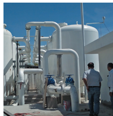
Construcción de planta de filtración directa de 112 L/s para pozo 5, en Gómez Palacio, Durango.
