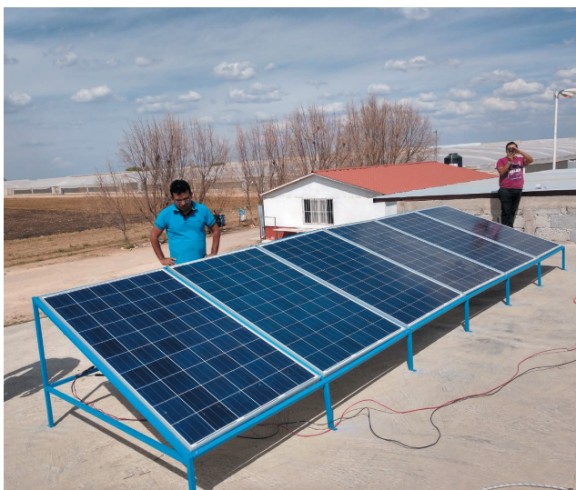
Instalación de sistema de bombeo con paneles solares.
