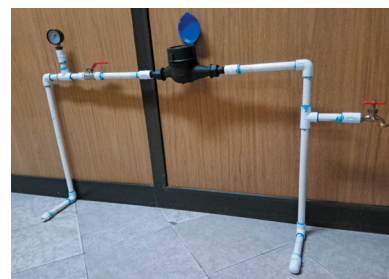
Construcción del módulo de pruebas para medidores domésticos.
