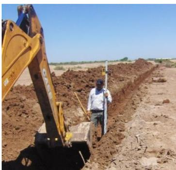
**Figura 7.4** Zanjeado para instalar drenaje subterráneo
