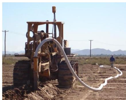
**Figura 7.5** Instalación de un sistema de drenaje subterráneo
