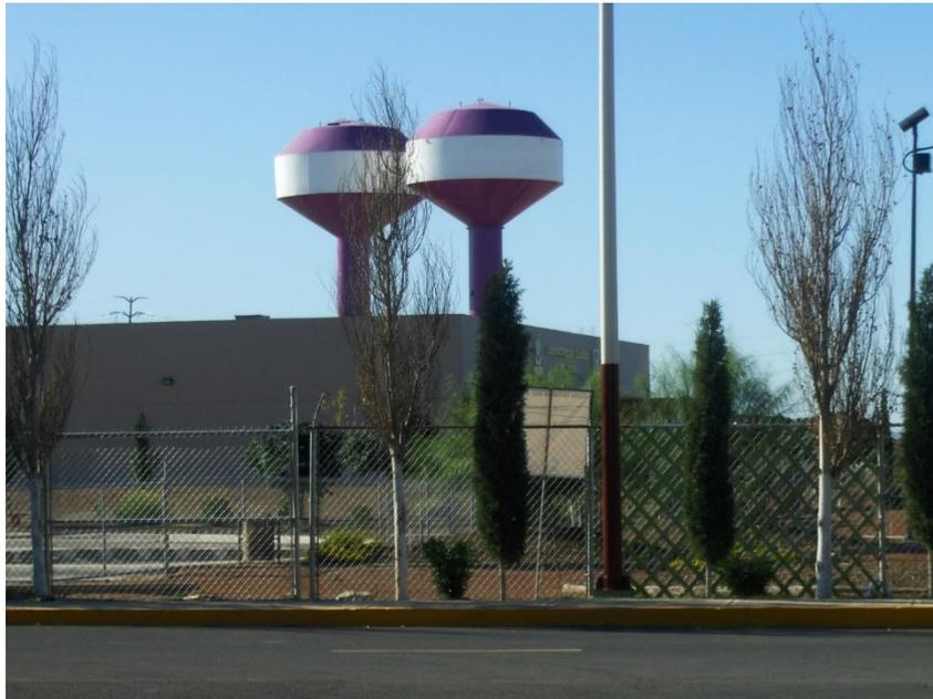
**Figura 2.3** Tanques elevados de almacenamiento de agua tratada para reúso en servicios al público
