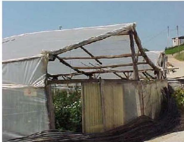
**Figura 2.28** Construcción básica a base de madera (FAO, 2004)
