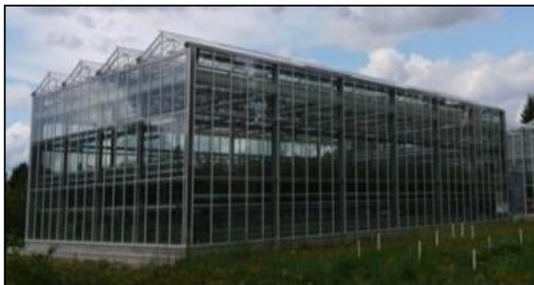
**Figura 1.7** Invernadero tipo venlo con paredes de vidrio
