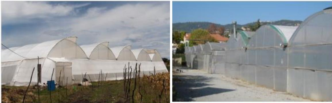
**Figura 5.24** Invernadero en batería A) tipo cenital y B) tipo túnel
