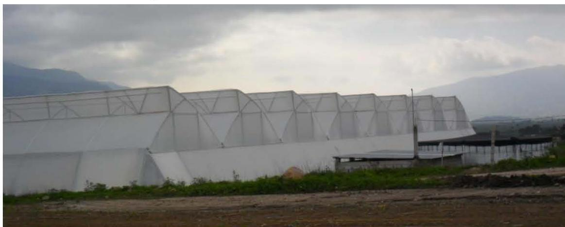
**Figura 2.18** Invernadero multimodular de ocho capillas tipo cenital
