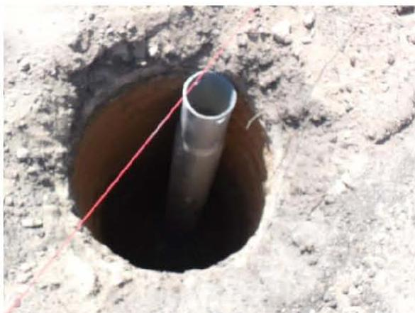
**Figura 2.20** Perforación para la colocación del concreto en la base de la estructura
