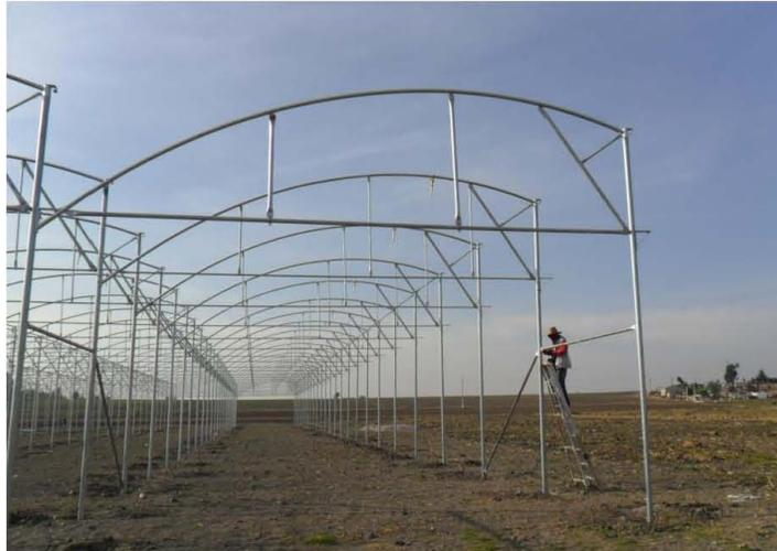
**Figura 2.9** Curvatura de un invernadero cenital tipo sierra
