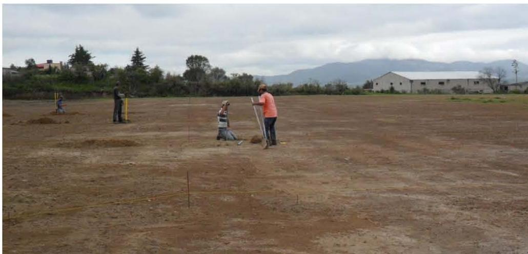
**Figura 2.17** Trazo y nivelación del invernadero multimodular
