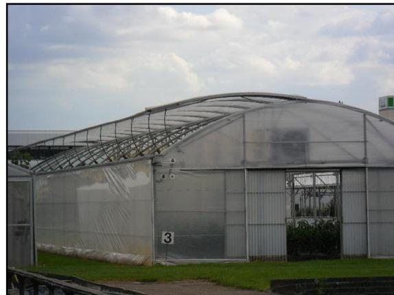
**Figura 1.9** Modelo multitúnel con ventilación mariposa
