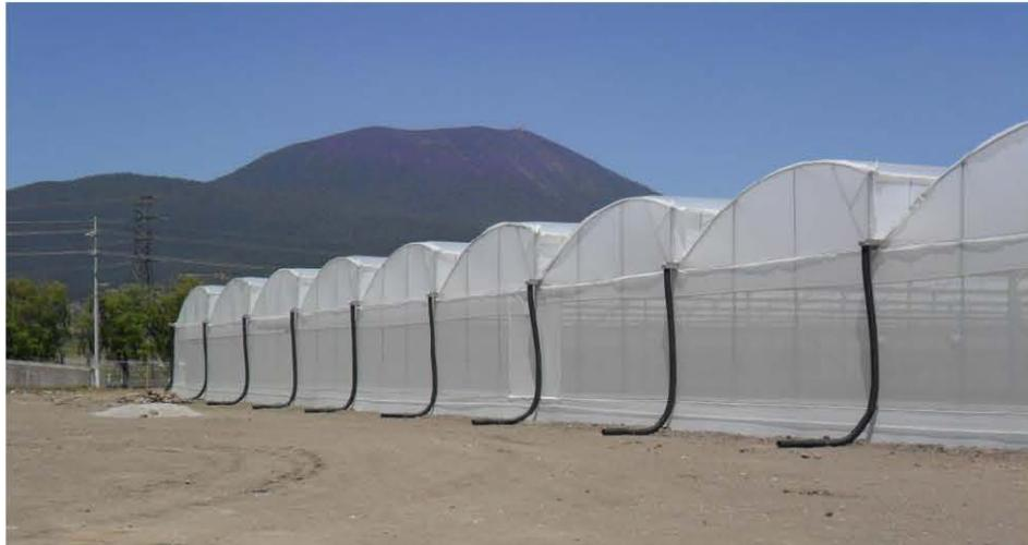
**Figura 2.12** Invernadero multimodular de 50 m de ancho
