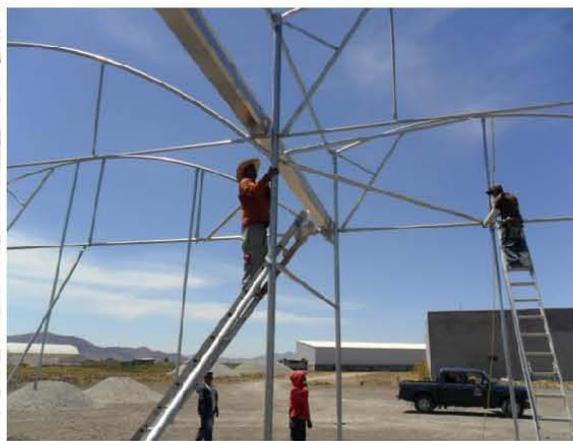
**Figura 2.21** Colocación de canaleta para captación de lluvia
