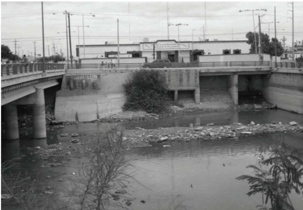
**Figura 99. Desagüe total en el Km 8+000 del canal Anzaldúas, actualmente en desuso al ser eliminada la represa del canal y rellenado el dren Reynosa Poniente, donde se descargaban totalmente las excedencias del canal hacia el río Bravo. El terreno federal, resultado del relleno del dren, fue utilizado para construir oficinas federales e instalaciones recreativas del municipio de Cd. Reynosa, Tam.**
