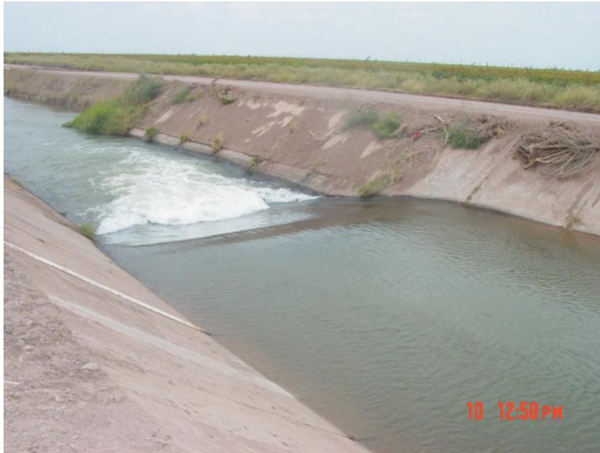
**Figura 57. Aforador de garganta larga sin estrechamiento de las paredes.**
