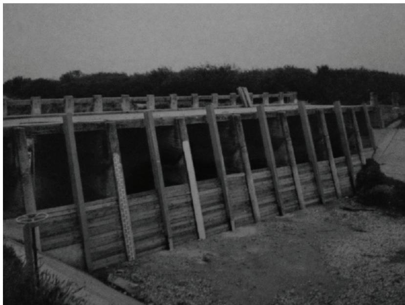
**Figura 73. Represa de agujas de madera con sección 3"x 6"x 6 pies (0.75m x 0.15m x 1.80 m) con diez claros de veinte agujas, cada uno y dos de diez agujas para un total de 220 piezas y capacidad de 25 m<sup>3</sup>/s. Represa actualmente sustituida por una represa de compuertas radiales, Km 121+440, canal Rode. Cortesía DR 026 Bajo Río San Juan, Tam.**
