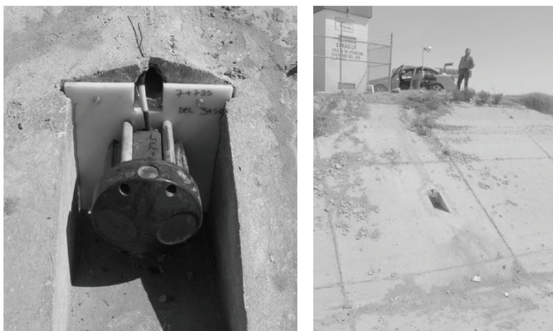
**Figura 51. Colocación de un sensor Doppler montado en placa de nailacero, en un “nicho”. Canal lateral 3+500, DR 017 Región Lagunera, Coah.-Dgo. Esta forma de montaje del sensor reduce sustancialmente el vandalismo, al no tener cables a la vista y los efectos provocado por los herrajes de aluminio.**
