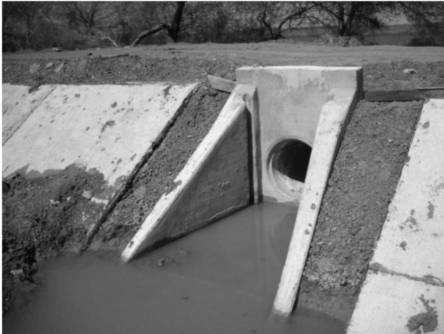
**Figura 84. Conducto preparado para colocar compuerta tipo Miller para toma granja. Canal 12+570 del DR 025 Bajo Río Bravo, Tam.**
