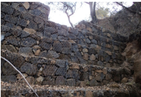
Figura 18. Presa de gavión y geocostales en la porción este de la subcuenca.
