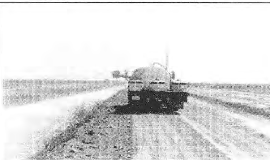
Foto 9.11. Tracto camión con aplicador selectivo.
