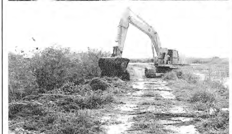
Foto 4.8. Extracción de lirio e hidrila en un almacenamiento, mediante una excavadora hidráulica
