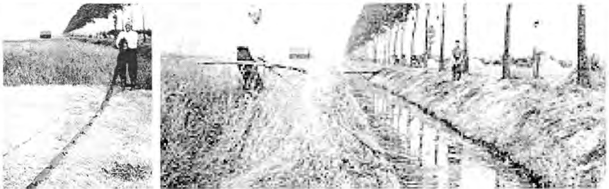
Foto 4.2 Cortadora de cadena para control de maleza suave en canales y drenes
