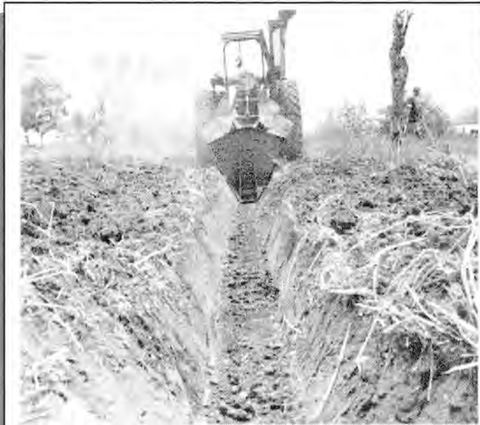
Foto 3.2. Colocación de drenaje subterráneo
