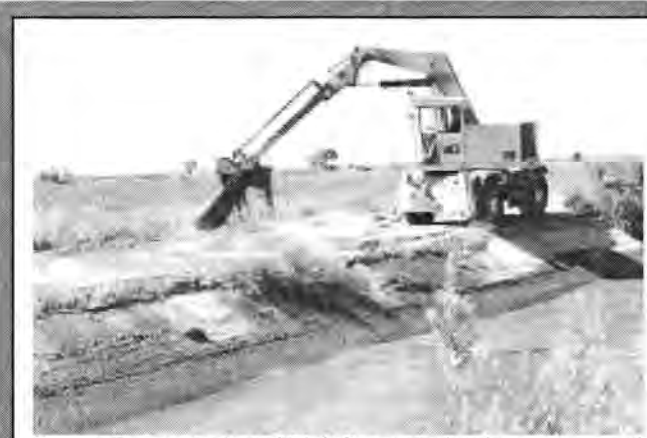
Foto 4.7. Excavadora hidráulica trabajando en un canal revestido
