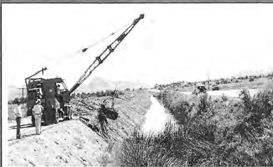
Foto 4.5 Extracción de tule en un dren colector, mediante una draga
