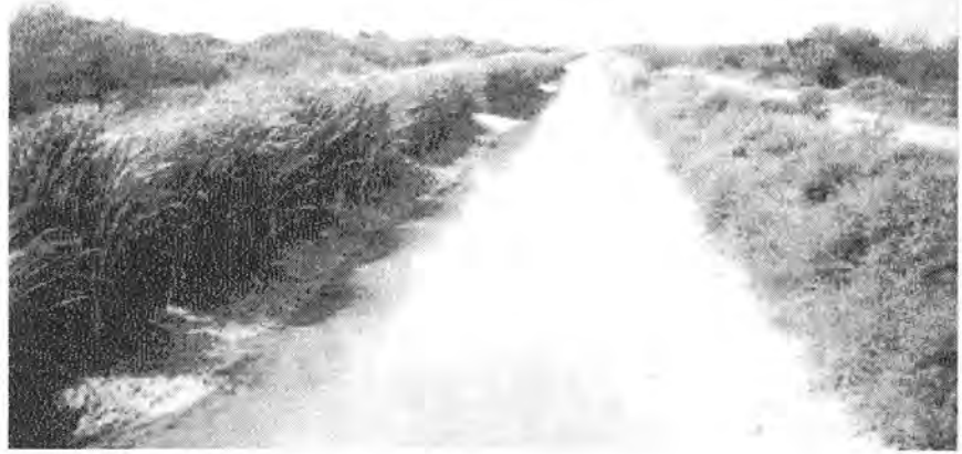
Foto 3.13. Acumulación de azolve
