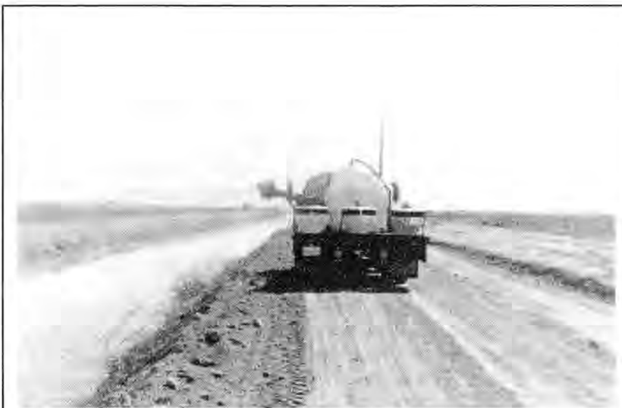
Foto 5.6. Equipo de aplicación con infrarojo.
