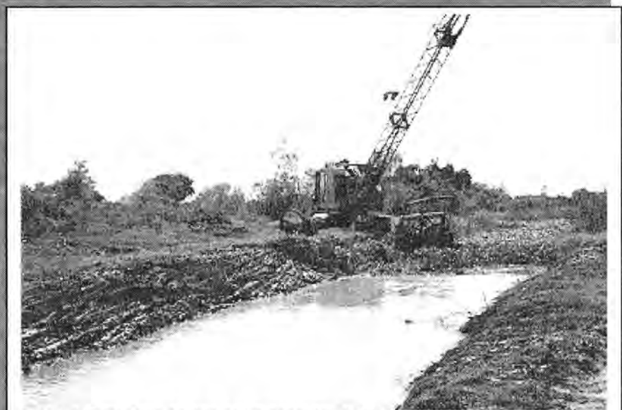
Foto 4.6 Extracción de lirio en un canal principal, mediante una draga
