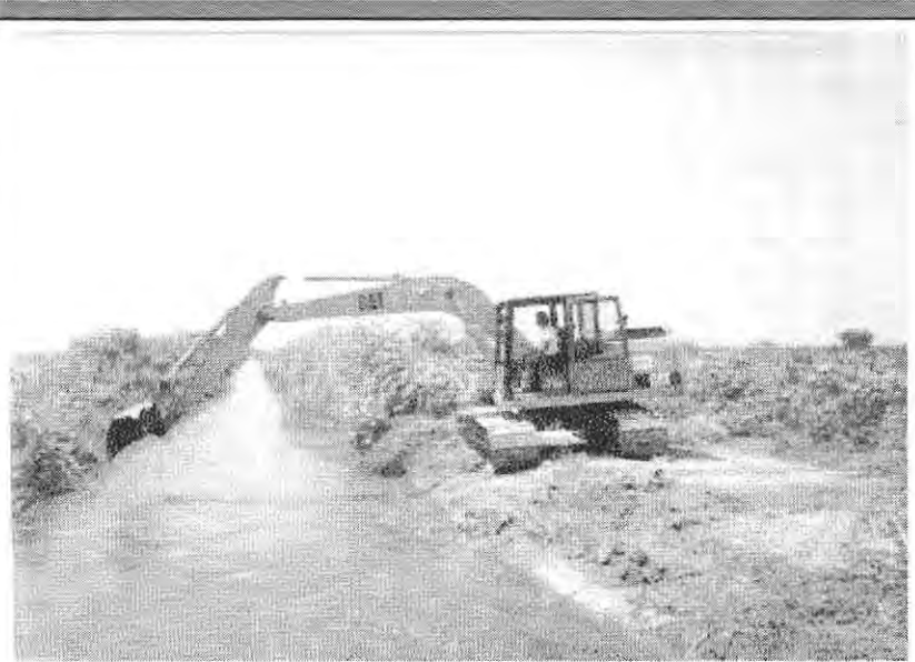
Foto 9.5. La maleza evita erosión de taludes.
