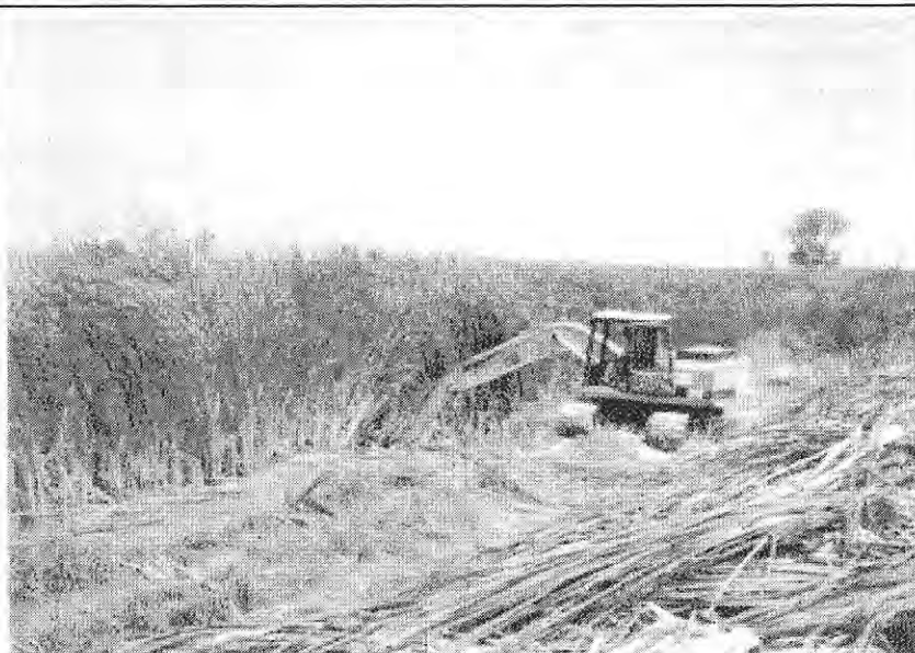
Foto 9.7. El equipo pesado se utiliza en la extracción de maleza y azolve de canales y drenes.
