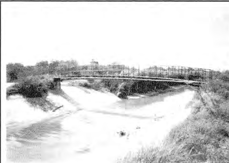
Foto 3.3. Tramo de canal revestido y sin revestir.
