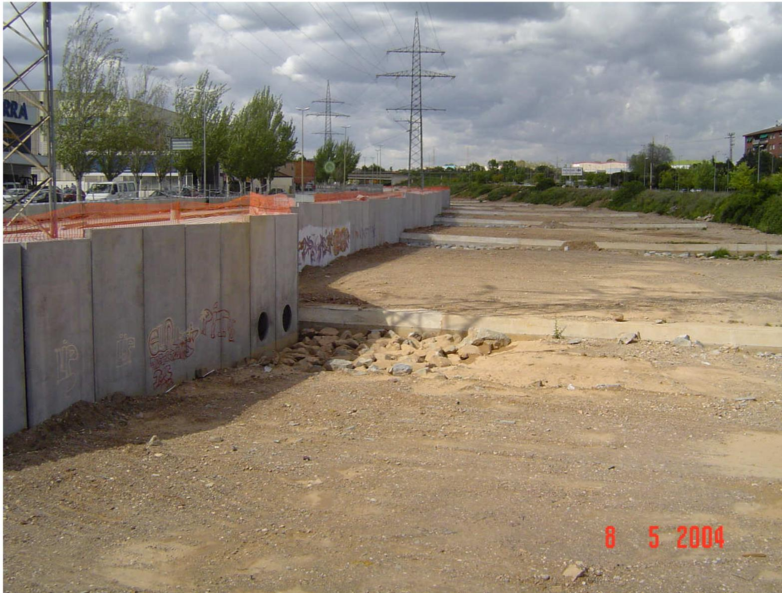
Control del perfil del lecho en ríos efímeros por medio de umbrales de fondo o traviesas: se presta a un modelo bidimensional (o por unidad de anchura: corte por un plano vertical del problema)
