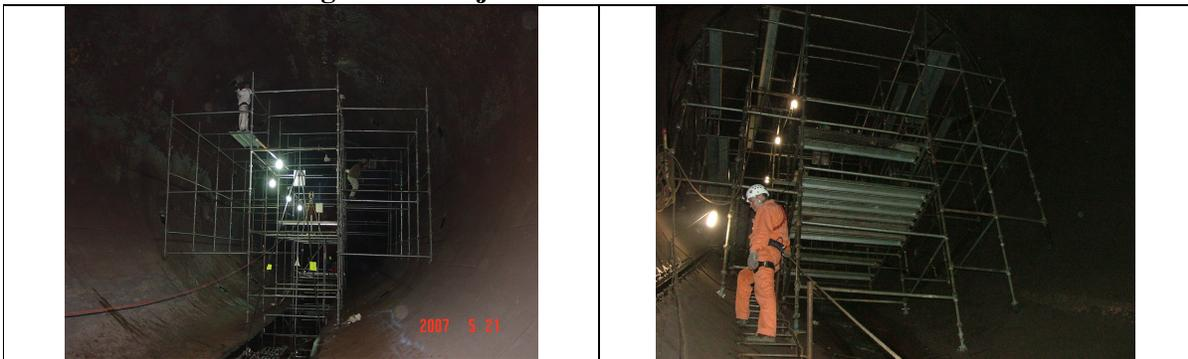
Colocación de estructura o andamios, con la finalidad de acceder a cualquier punto de la tubería de presión, en la sección donde será instalado el sistema de medición.
