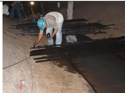
Limpieza mecánica con carda eléctrica y posterior barrido mediante solvente, finalizando con la aplicación de alquitrán de hulla como protector anticorrosivo.
