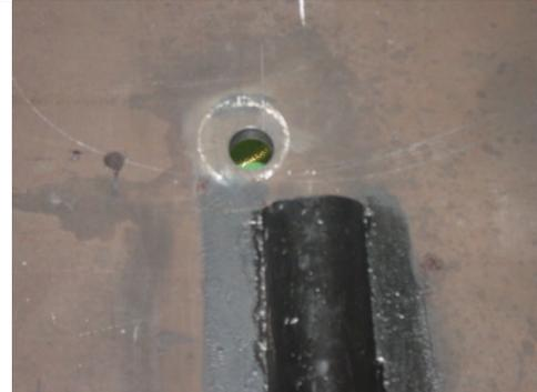
Ubicación del punto de salida de las líneas de transmisión y perforación del ducto de presión previo a la colocación del sistema para sacar el cableado.
