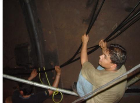
Arrastre de cable coaxial RG-59 a través de sus protecciones mecánicas..
