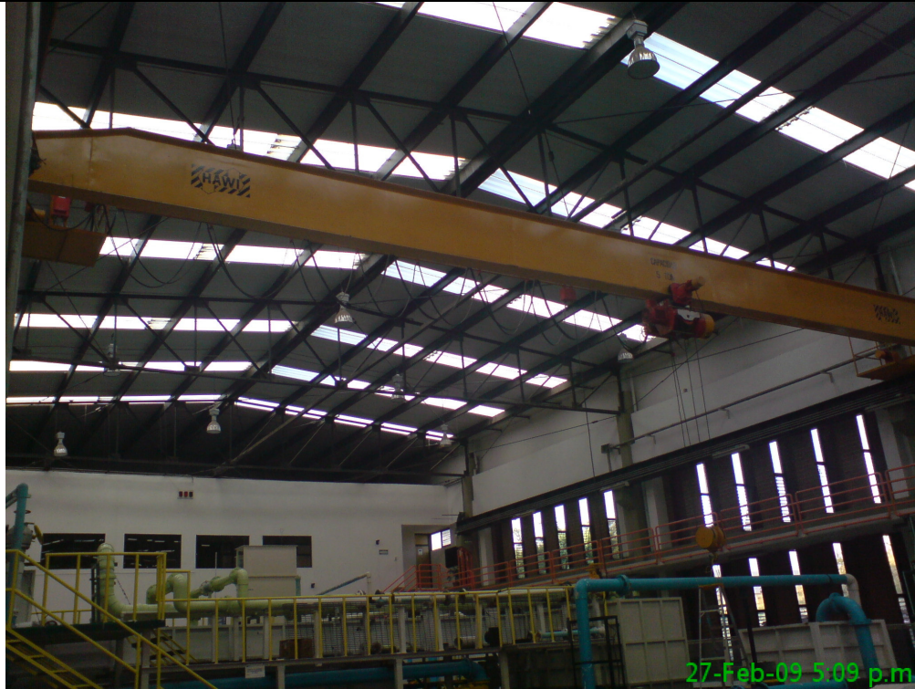
Figura 1. Mantenimiento a la Grúa Viajera del lado derecho del Laboratorio
