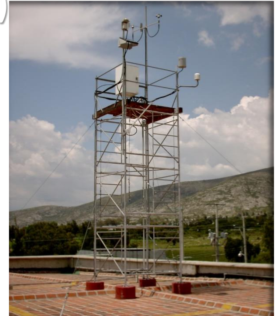
Estación de instalada en Tecamachalco , Puebla
