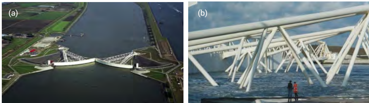
Figura 12.7. Sistema de diques en Países Bajos. a) Dique Maeslant, con sus puertas cerradas, b) Estructura del dique Maeslant. Fuente: holland.com
