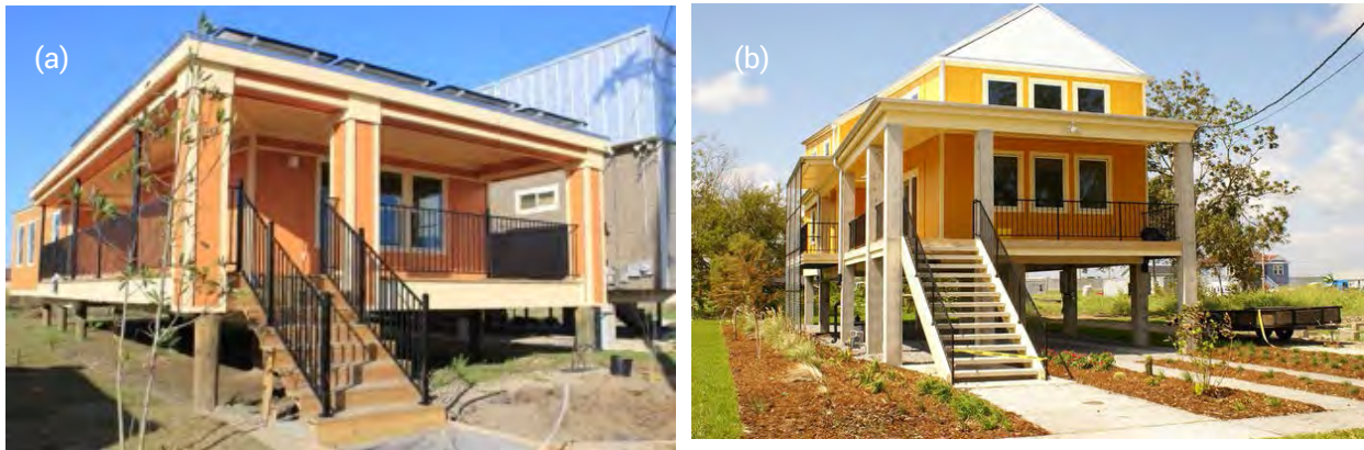
Figura 12.8. Casas diseñadas para resistir vientos de huracán categoría 5 e inundaciones por marejadas ciclónicas. Barrio Nueve, Nueva Orleans.
