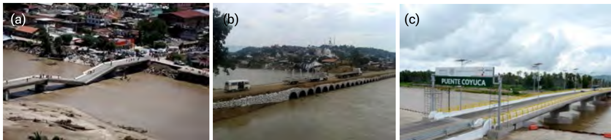
Figura 12.6. Puente Coyuca, estado de Guerrero: a) Colapso del puente, b) Puente provisional construido 15 días después del colapso, c) Nuevo puente Coyuca construido un año y dos meses después. Fuente: www.eluniversal.com.mx
